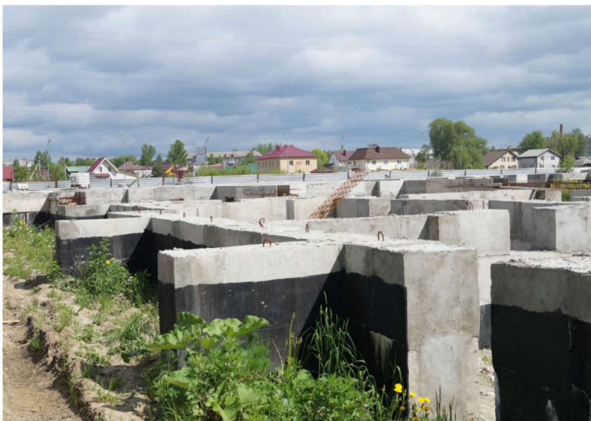
Фото 2. Объект незавершенного строительства (II очередь)
