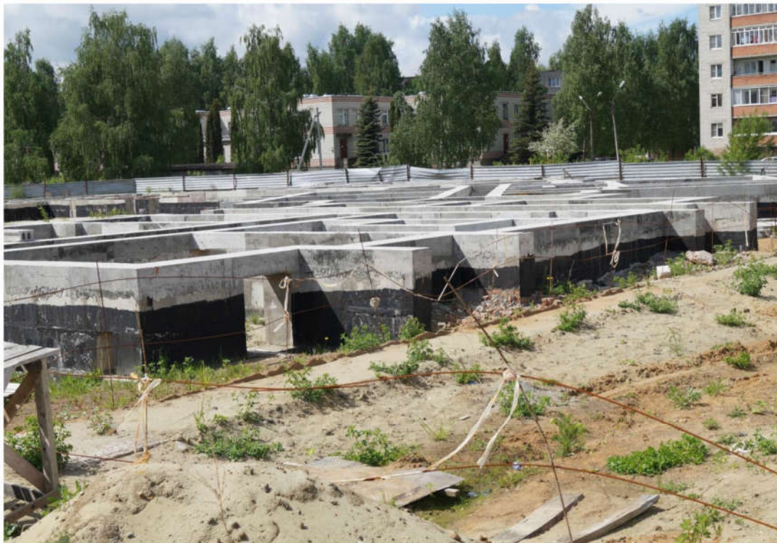
Фото 3. Объект незавершенного строительства (I очередь)
