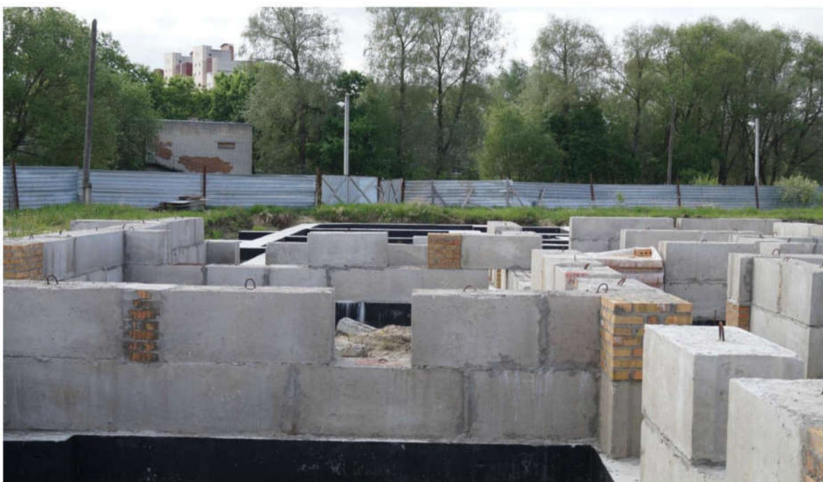
Фото 1. Объект незавершенного строительства (III очередь)
